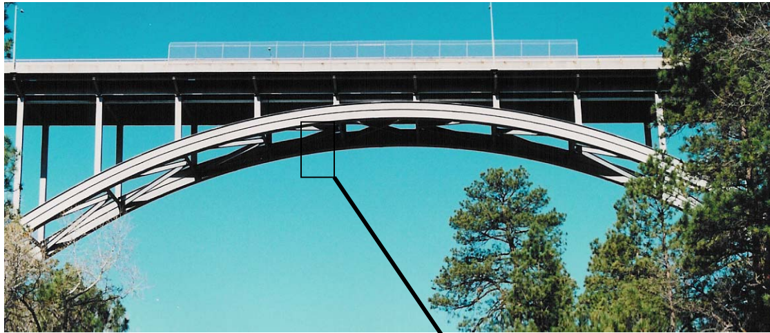
Canyon Bridge, Los Alamos, NM
